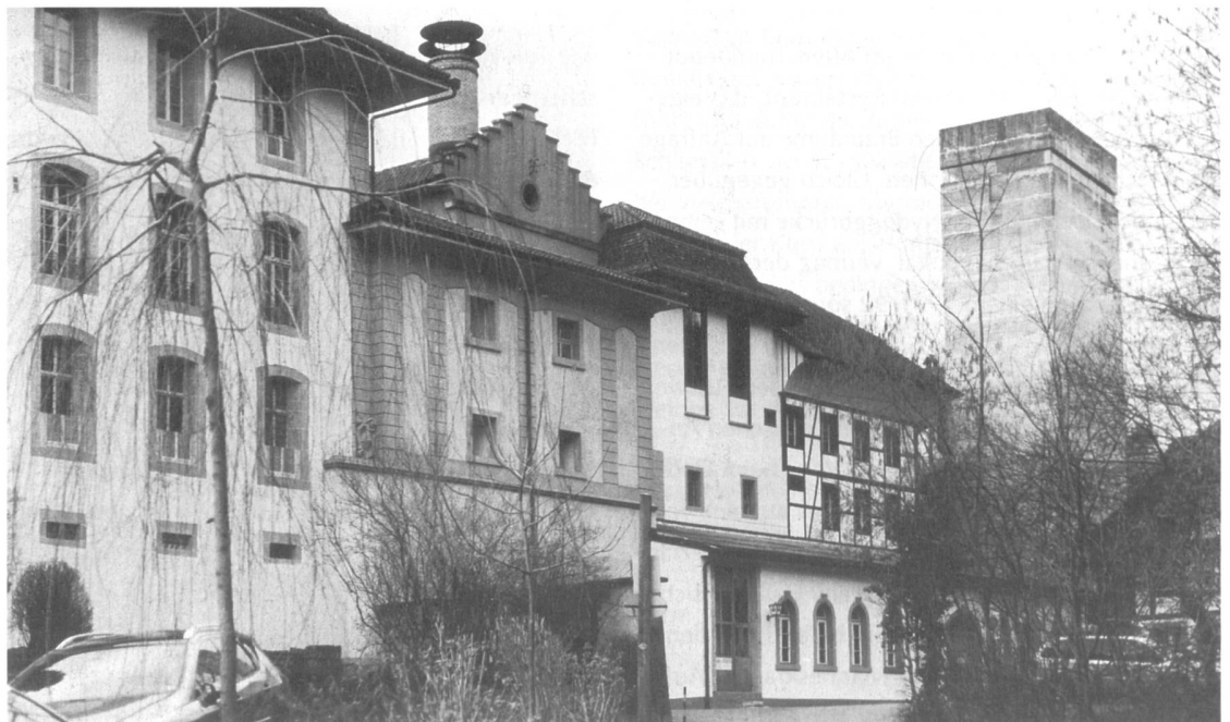
Schloss Reichenbach bei Zollikofen (links) mit anschliessenden ehemaligen Brauereibauten samt Malzsilo
