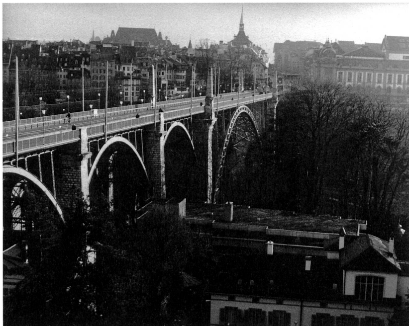
Die Kornhausbrücke mit markantem Hauptbogen und mehreren, zwischen Jurakalkpfeilern eingespannten Nebenbogen, 1896-98 unter Leitung des Berner Ingenieurs Simons von der Krienser Firma Bell konstruiert
