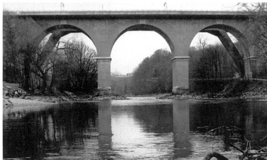
Die natursteinernerne Tiefenaubücke aus den Jahren 1846–50 mit erheblich störenden Fahrbahnüberkreuzungen von 1977. Im Hintergrund die Brücke der RBS von 1965
