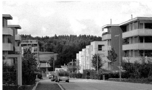
Die Wohnüberbauung Brünen
