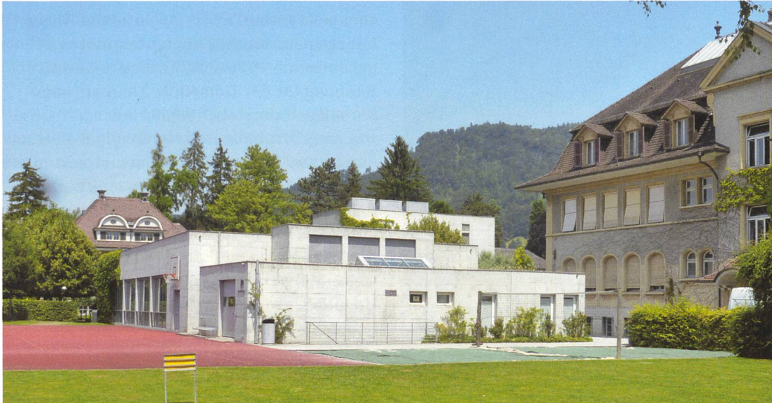
< Atelier 5: Lehrerinnen-seminar Thun. Rechts im Hintergrund ist das Dach der Villa Lüthi zu sehen, links das Schulhaus von 1921-1922, dazwischen die neue Turnhalle.
