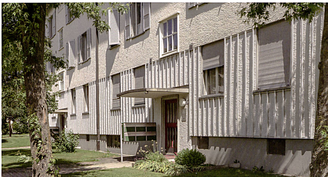
► 37 Der klar geschnittene Gebäudekörper mit den Landstilelementen wie z. B. dem Holzlattenrost, den Sprossenfenstern oder den geschwungenen Vordächern über den Eingängen.
