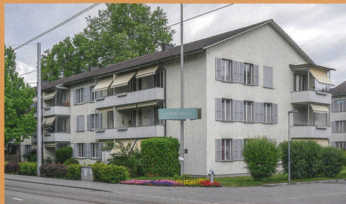
▲ 2 Seit 2013 gilt die ab 1949 von der Familienbaugenossenschaft (heute FAMBAU-Genossenschaft) errichtete Meienegg deshalb als frühestes noch erhaltenes soziales Wohnbauprojekt in Bern.
