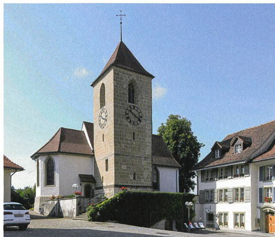
► 6 Die Kirche © von 1575 mit dem Turm von 1526. Rechts das alte Pfarrhaus.
