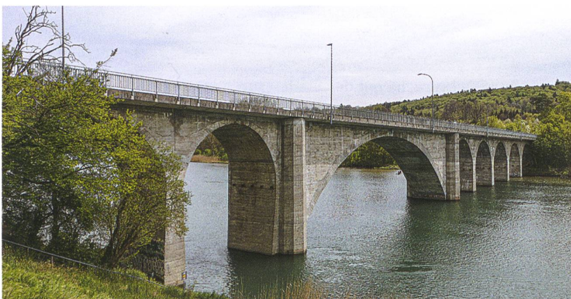
▼ 6 ... wurden die BKW 1917 zum Bau der neuen, 174 m langen und zwei-spürigen Hinterkappelenbrücke verpflichtet. Die armierte Betonbogenbrücke wurde 1920 eröffnet.
