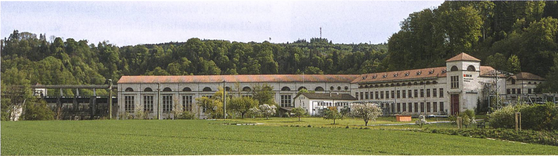
◀ 12 Die Gesamtanlage des Kraftwerks vom Unterlauf aus gesehen: links die Talsperre mit dem Wehr und dem Maschinenhaus, rechts angewinkelt das Schaltheus, dahinter das freistehende Ölhaus.
