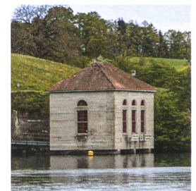
◀ 15 Vorplatz zwischen Maschinen- und Schaltheus mit Verbindungshalle.
