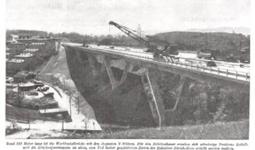
Rechts wird die Fahrspur mit verschiedenen Stahlschienen erstellt. Der Bildrand zeigt die Abschränkung, die auf der Wiggertal-Überführung zu sehen ist.
