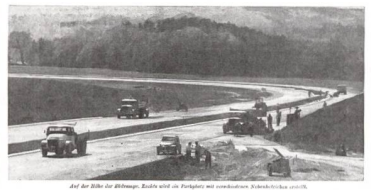
Auf der Höhe der Härkingen. Rechts wird die Fahrspur mit verschiedenen Stahlschienen erstellt.
