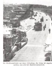
Die Stahlschienen von einer Leitwerke. Der Bildrand zeigt die Abschränkung, die auf der Wiggertal-Überführung zu sehen ist.
