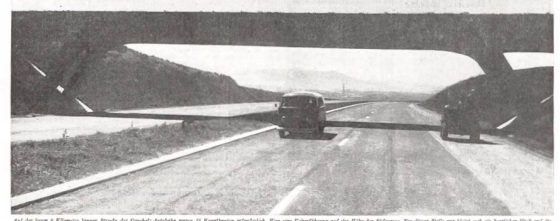
Auf der linken N1-Strasse liegen Brücken der Eisenbahnstrecke, die 12 km zwischen Ottingen und Härkingen verläuft. Hier eine Überführung auf der Höhe der Härkingen. Von dieser Stelle aus führt auch die Autobahn nach Bern. Im Bild unten, das Olten und – bei Olten – auf der Wiggertal und Wiggertal.
