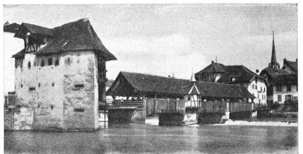
DIE REUSSBRÜCKE ZU BREMGARTEN, DIE DURCH EINEN NEUBAU ERSETZT WERDEN SOLL
