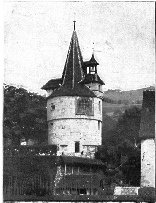
== DER KAPUZINERTURM IN ZUG == == LA TOUR DES CAPUCINS A ZOUG == Verlag der Schweizerischen Bauzeitung, A. Jegher in Zürich II
