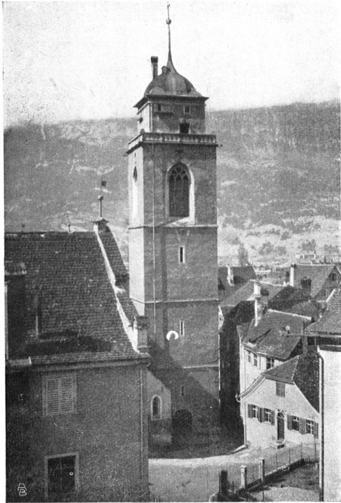
DER MARTINSTURM IN CHUR vor der vor etwa 15 Jahren erfolgten Renovation LA TOUR SAINT-MARTIN A COIRE, avant la rénovation
