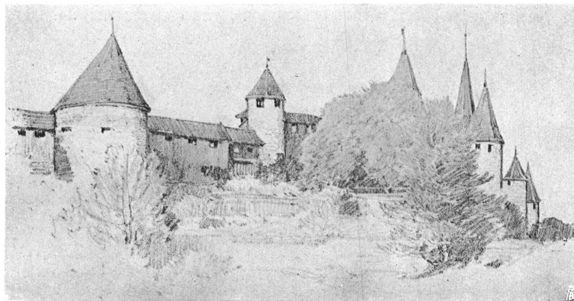
SÜDOSTSEITE DER STADTMAUER VON MURTEN == COTÉ SUD-EST DES REMPARTS DE MORAT ==
