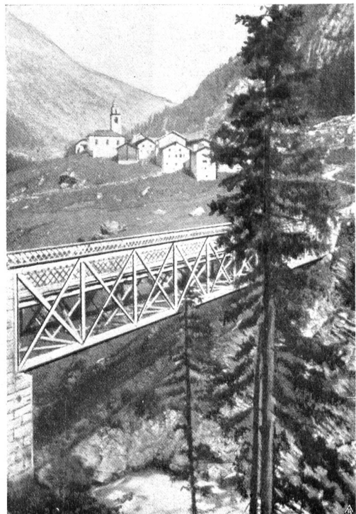
EISERNE BRÜCKE BEI INNER-FERRERA (Graubünden), eine hässliche Eisenkonstruktion in einer Gegend, wo Material genügend vorhanden wäre zu einem Steinbau PONT EN FER PRÈS INNER-FERRERA (Grisons). Construction hideuse dans une contrée où les matériaux ne faisaient pas défaut pour un pont en pierre
