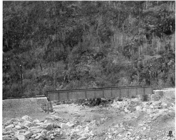
EISERNE BRÜCKE DER MAGGIATALBAHN ÜBER DEN BACH VON AVEGNO, 100 m unterhalb der neben abgebildeten malerischen alten Strassenbrücke aus Stein PONT EN FER DANS LE VAL MAGGIA, à une distance de 100 m du vieux pont reproduit à gauche
