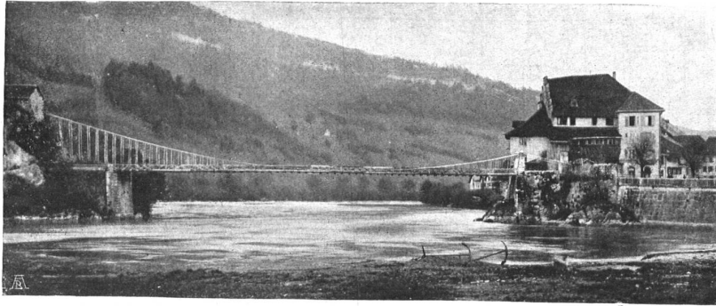
DER DRAHTSEILSTEG ZU AARBURG, der in Bälde durch einen Neubau ersetzt werden soll PONT SUSPENDU A AARBURG, qui sera remplacé par une construction nouvelle
