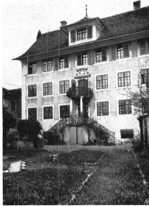
Die Gartenfassade des „Seehofs“ zu Meilen, mit den von der Gottfried Keller Stiftung und der Landesmuseumskommission für das Landesmuseum in Zürich angekauften Mittelpartie — La façade jardin, avec le balcon et la rampe d'escalier achetés par la fondation Gottfried Keller et la Commission du Musée National
