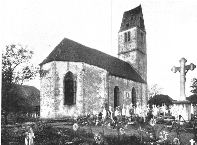
DIE ALTE KIRCHE ZU WANGEN a. A. (Kanton Solothurn), die vor kurzem abgerissen wurde, um einem Neubau Platz zu machen. (Vergl. unsere Mitteilung „Kirchenrenovationen im Kanton Solothurn“ S. 72.) Nach einer Aufnahme aus dem Archiv der Schweizer. Gesellschaft für Erhaltung historischer Kunstdenkmäler. L'ÉGLISE DE WANGEN (Soleure) détruite récemment pour faire place à une construction neuve (voir nos Communications page 72). Cliché propriété des Archives de la „Société Suisse des Monuments historiques“.
