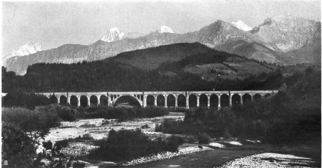
DER KANDERAQUÄDUKT DER KANDER-HAGNECKWERKE. ¶ Als vorzügliches Beispiel einer der grossartigen Landschaft aufs trefflichste angepassten gewaltigen Wasserüberführung. Entworfen und gebaut von der Firma Müller, Zeerleder & Gobat in Zürich und Bern. (Vergl. Zeitschriftenschau Seite 10 des Inseratenteils)
