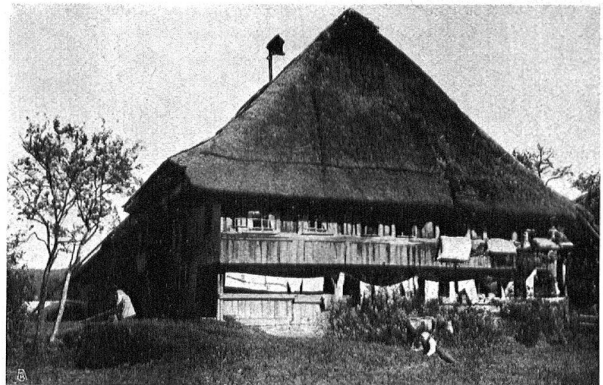
STROHHAUS BEI ZOFINGEN MAISON AU TOIT DE CHAUME PRÈS ZOFINGUE
