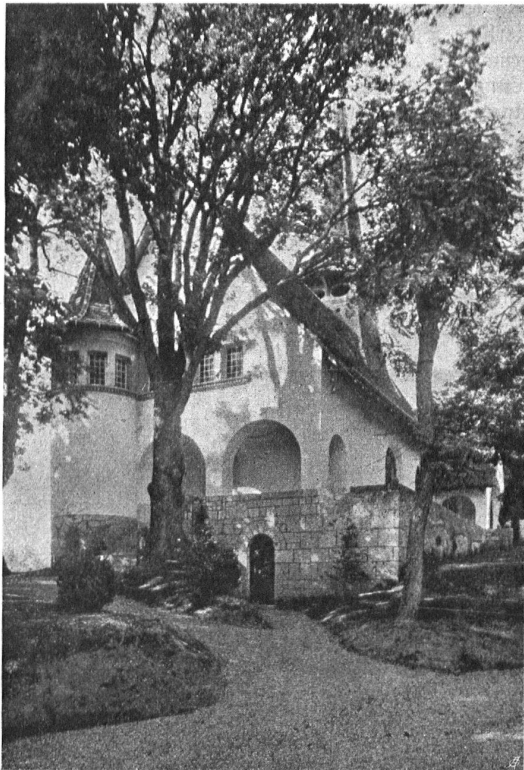
Die Inselkirche in Bern Arch. B. S. A. Karl In der Mühle, Bern
