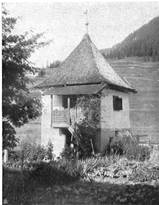
EIN GARTENHAUESCHEN AUS EINEM BUENDNER DORFE UN PAVILLON DANS UN VILLAGE GRISON Aufnahme von Schobinger & Sandherr in St. Gallen
