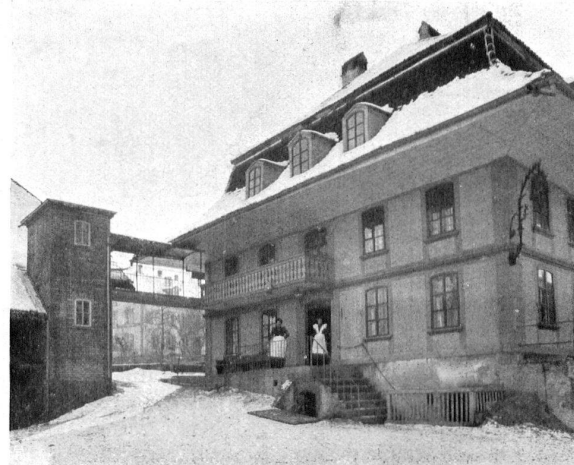
GASTHOF ZUM KREUZ IN DURRENROTH mit häss- licher moderner Abortanlage (vergleiche das Bild nebenan) HOTEL DE LA CROIX A DURRENROTH, avec combinai- son malheureuse des W. C. (Comparer avec le bon exemple!)
