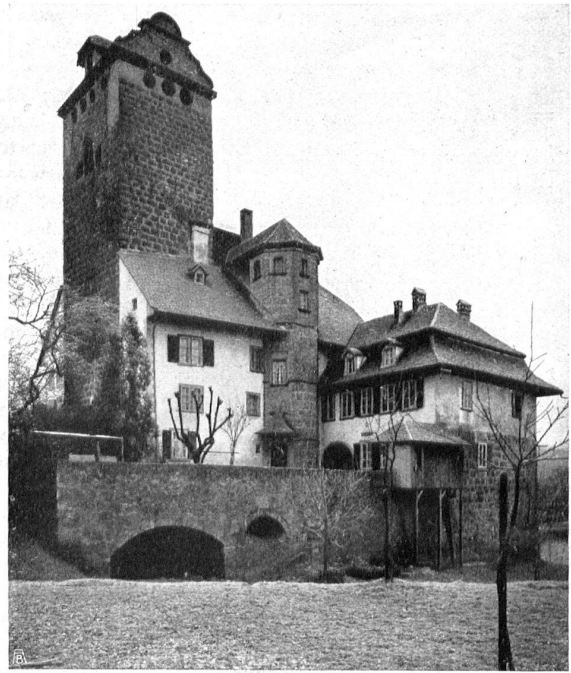
DAS SCHLOSS IN AARWANGEN, vorzügliches Beispiel har- monischer Gruppierung von Bauteilen verschiedener Stilepoelen CHATEAU D'AARWANGEN; excellente combinaison d'édi- fices d'époques diverses
