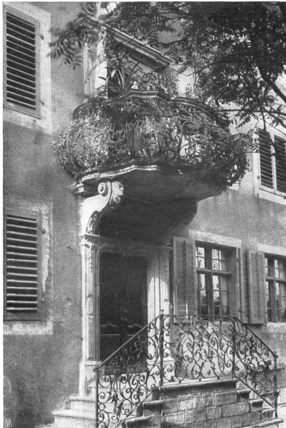
STRASSENPORTAL VOM SEEHOF IN MEILEN. Ins Ausland verkauft. Vergl. Jahrg. II, 1907, S. 93. Photographie von René Chapallaz, Architekt in La Chaux de Fonds
