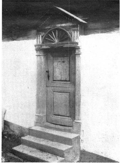
TÜRE EINES HAUSES IN CONTERS (Prättigau) Photographie von Architekt R. Gaberel , Davos UNE PORTE A CONTERS (PRÄTTIGAU) Photographie de M. R. Gaberel , arch., à Davos
