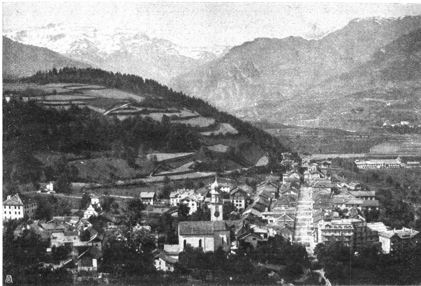
Ansicht einer Graubündner Ortschaft, durch eine moderne geradlinige Avenue un schön erweitert. Vue d'une localité dans le canton des Grisons, fâcheusement agrandie par une moderne avenue rectiligne.
