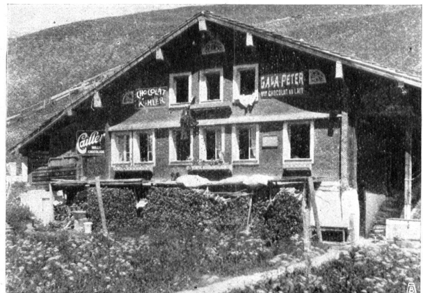
Altes reizvolles Holzhaus in Engelberg, entstellt durch aufdringliche Reklameplakate. — Charmante vieille maison de bois à Engelberg, surchargée de vilaines et criardes affiches.
