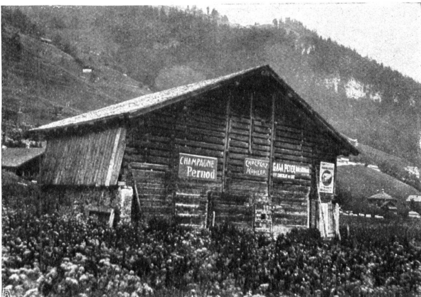
Malerisches altes Stallgebäude in Engelberg, entstellt durch aufdringliche Reklameplakate. — Pittoresque vieille étable à Engelberg, muée en tableau d'affichage.
