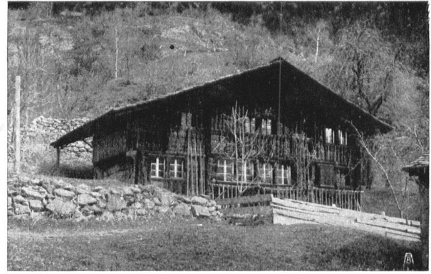
Abb. 5. Bauernhaus in Silenen, teilweise noch mit Schiebläden und geschweiften Fensterbrettern. — Fig. 5. Ferme à Silenen; quelques-unes des fenêtres ont encore des ais chantournés et des volets à coulisse.
