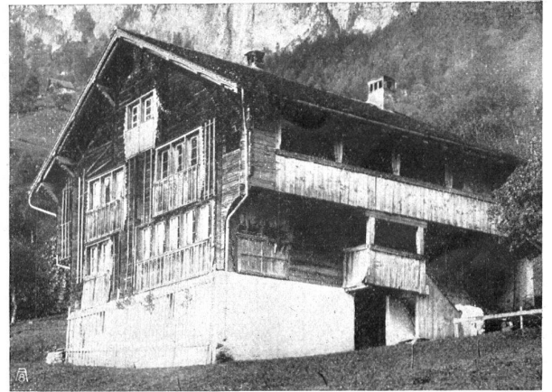
Abb. 21. Bauernhaus in Bauen, des Schmuckes durch Obstspalier entkleidet. Fig. 21. Ferme à Bauen défigurée par la destruction d'un pittoresque poirier.
