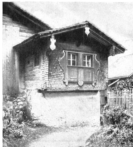
Abb. 18. Sogenanntes „Bischofszimmer“ in Isenthal. Fig. 18. La „Chambre de l'Evêque“ à Isenthal.
