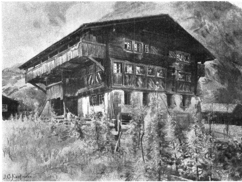
Abb. 9. Das Muheimsche Haus in Erstfeld im alten Bestand.
