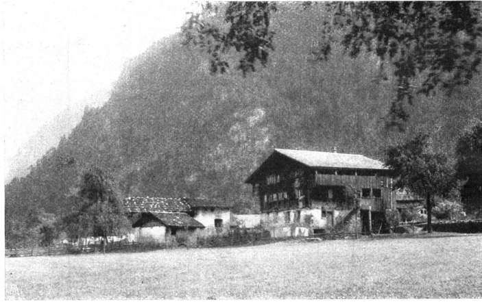
Abb. 8. Das „rote Haus“, Sitz des Landammanns Sebastian Muheim († 1694) in Erstfeld, daneben altes Holz- und Steinhaus. — Photographie von Dr. K. Gisler, Altdorf.
