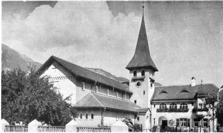
Kirche und Pfarrhaus in Landquart. Mit bescheidenen Mitteln ermöglichte, geschlossene moderne Lösung in heimatlicher Art. Erbauer: Architekten B. S. A. Schäfer & Risch, Chur. Aufnahme von Micholl, Schiers.
