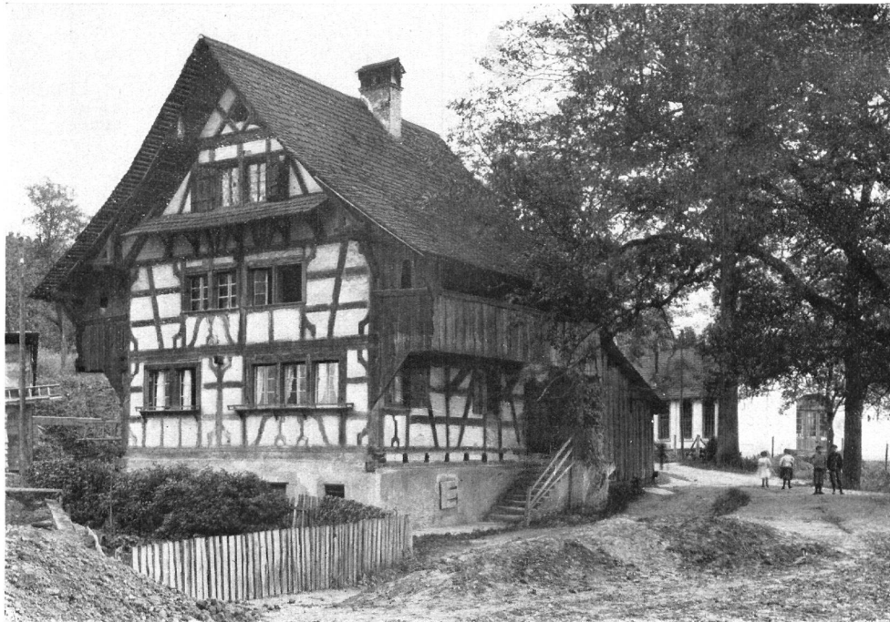
Abb. 13. Steghof in Luzern. Typischer Riegelbau. Aufnahme von N. Hinder, Luzern. — Fig. 13. Steghof à Lucerne. Exemple typique de construction en colombage. Cliché N. Hinder, Lucerne.
