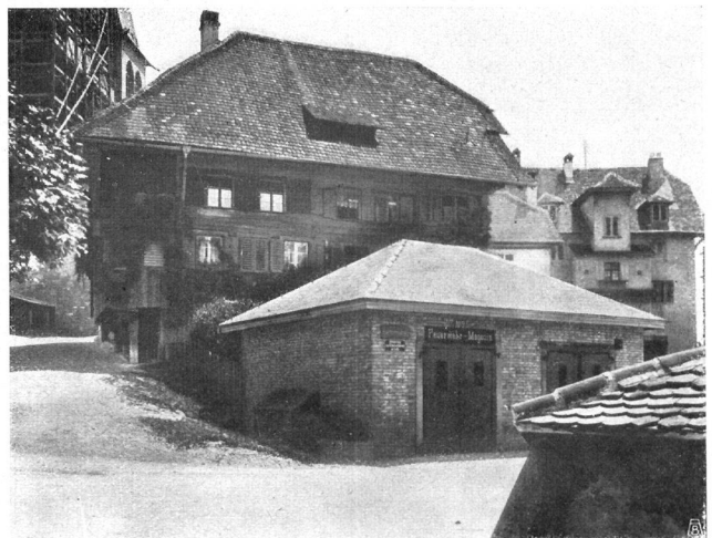
Abb. 15. Holzhaus im Hof, Luzern. — Fig. 15. Maison en bois „im Hof“, à Lucerne. Gegenbeispiel : Die schöne Gruppe der alten Pfarrhäuser mit der Kirche ist durch die hässlichen Formen und Farben eines städtischen Feuerwehrdepots völlig beeinträchtigt. Aufnahme von N. Hinder, Luzern. — Mauvais exemple : Le groupe pittoresque que formaient la vieille cure et l'église est complètement gâté par les formes disgracieuses et les couleurs criardes d'un hangard aux pompes élevé par la ville. Cliché N. Hinder, Lucerne.
