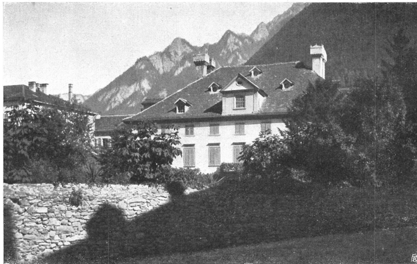
Das Alte Gebäu (von Salis'sches Haus). Blick von der Gartenseite. Hier dominiert besonders das mächtige Dach, belebt durch Kamine und Dachlücken in originellen Formen. Auf dieser Seite ist der Dekor noch schlichter als an der Hauptfassade. Man beachte, wie wundervoll sich die kräftige Silhouette in das von Bergen umrahmte Landschaftsbild einfügt. — Maison von Salis vue du jardin. Ici domine avant tout le toit animé par des cheminées et des lucarnes d'une forme originale. La façade de ce côté est plus simple encore que de l'autre. Remarquer avec quelle vie la vigoureuse silhouette se détache de la montagne.
