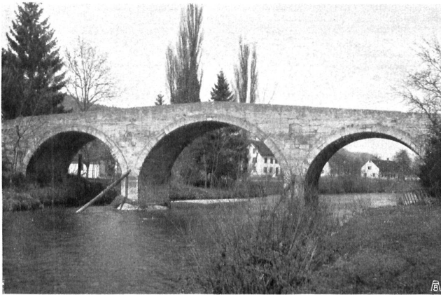
Die Brücke von Rorbas - Freienstein. Durch die Grösse ihrer Proportionen, durch den Schwung der Bogenführung und die Einfachheit des ganzen Aufbaues gemahnt diese Brücke fast an antike Werke verwandter Art. Man hofft die Brücke modernem Verkehr anpassen zu können, ohne sie opfern zu müssen. Le pont de Rorbas-Freienstein. Le pont rappelle la sévère beauté de certaines constructions antiques par la grandeur monumentale de ses proportions, par la courbe élégante de ses arches et par la simplicité de l'ensemble. On espère réussir à conserver ce pont tout en l'adaptant aux exigences de la circulation moderne.
