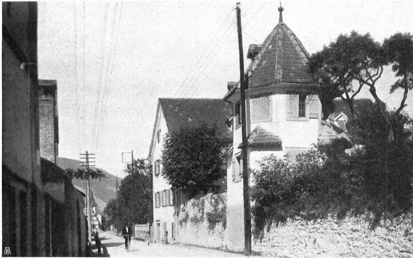
Das Haus zur Kante an der Masanserstrasse. Die Wirkung der besonders reizvollen Turmpartie wird durch die schlecht placierte Telegraphenstange beeinträchtigt. ::
