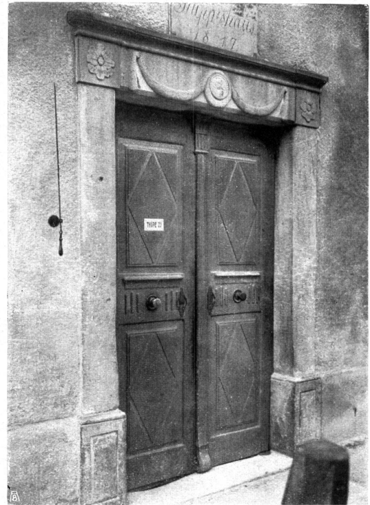
Portal am Stuppishaus an der Masanserstrasse. Mit seinem einfachem Schmuck wirkt das Portal bedeutend, da es als Ganzes künstlerisch empfunden ist. — Porte de la maison Stuppis, dans la Masanserstrasse. Malgré la simplicité de ses ornements cette porte est d'un grand effet et d'un art consommé.
