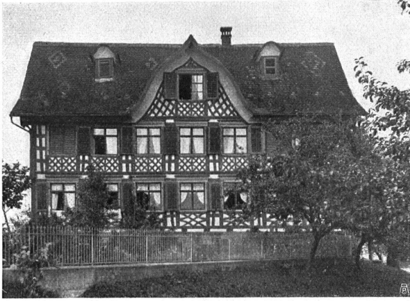
Abb. 6. Gutes Beispiel. Restaurant in Sonnenberg bei Amriswil. Verbindung eines Barockgiebels mit Fachwerkbau. — Fig. 6. Bon exemple. Restaurant à Sonnenberg, près d'Amriswil. Combinaison d'un pignon de style baroque avec la construction en colombage.
