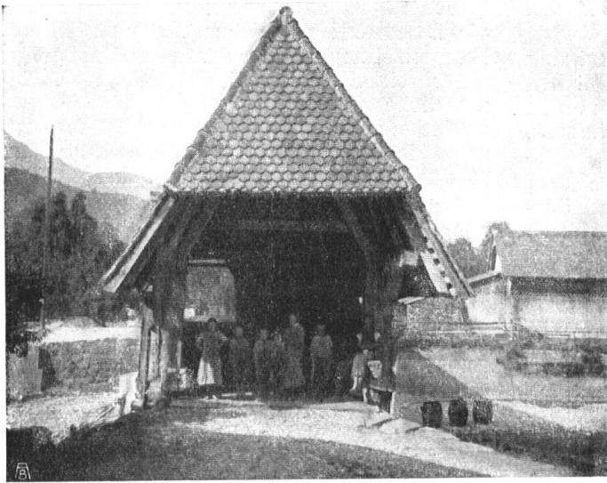
Hölzerne Brücke in Hinteribach, Kanton Schwyz. Bemerkenswert der elegante Brückenkopf. Das Bauwerk musste diesen Herbst einer Betonkonstruktion weichen. — Pont de bois à Hinteribach , canton de Schwyz. Remarquer l'élégante silhouette de la tête du pont. Cette construction caractéristique a dû malheureusement faire place à un pont en béton.
