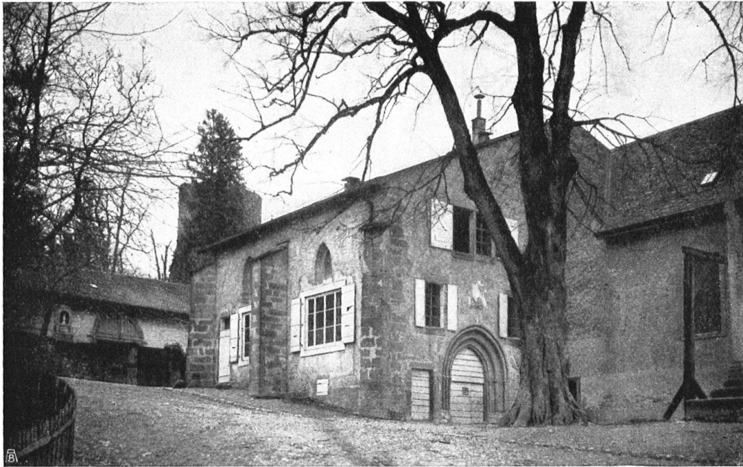
Fig. 14. La chapelle Sainte-Catherine (actuellement école et hangar). Les belles fenêtres ogivales de la façade Nord ont été malheureusement mutilés, il est à souhaiter qu'on les remette en état, lorsque l'école sera transférée dans le nouveau bâtiment projeté. Les figures très primitives des chapiteaux du porche sont seules de leur espèce sur territoire genevois. Cliché R. Gilli , Genève. — Abb. 14. Die Katharinenkapelle (z. Z. Schule und Schuppen). Die schönen gotischen Fenster der Nordfassade sind leider verstümmelt worden. Man kann nur wünschen, dass sie wieder instand gesetzt werden, wenn die Schule einmal das neue projektierte Heim bezogen hat. Die sehr primitiven Figuren an den Säulenkapitellen der Vorhalle sind in ihrer Art einzig auf Genfer Boden. Aufnahme von R. Gilli , Genf.
