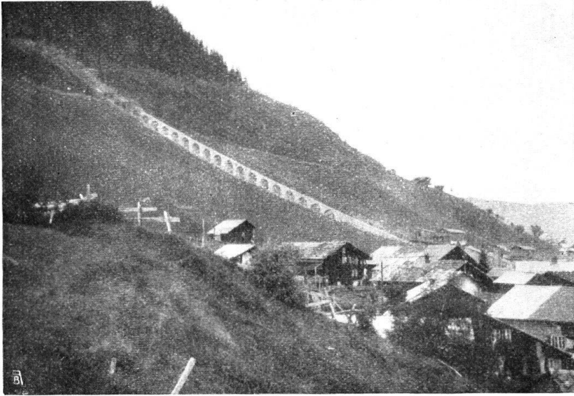
Abb. 6. Im Bau begriffene Drahtseilbahn für Wintersport in Mürren. Der hochgelegte Bahnkörper durchschneidet die Landschaft in hässlicher Weise. Aufnahme von Fr. Rath, Basel. — Fig. 6. Un funiculaire en construction, destiné aux sports d'hiver, à Mürren. Cette ligne surélevée coupe le paysage de la façon la plus désagréable. Cliché Fr. Rath, Bâle.
