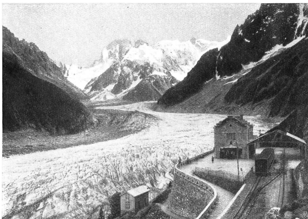
Abb. 25. Blick vom Montanvert nach Anlegung der Eisenbahn. Auch hier ist es dem „Wunderwerk der Technik“ gelungen, die Natur ihres ursprünglichen Reizes zu berauben. Aufnahme von Wehrli A.-G., Kilchberg. Fig. 25. Le même paysage après la construction. Commentaires inutiles! Cliché Wehrli S. A., Kilchberg.
