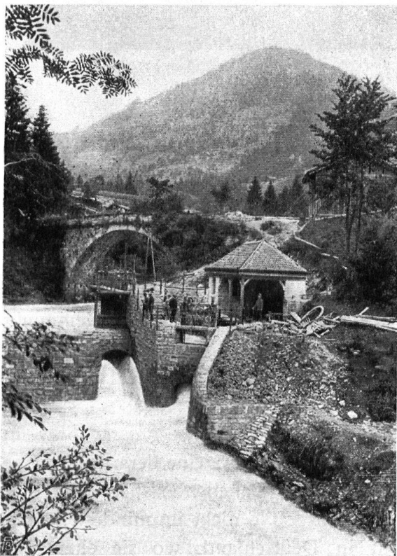
Abb. 14. Sehr schöne Wasserfassung bei Trois-Torrents an der Vièze, Wallis. Aufnahme des Bureau für schweiz. Landeshydrographie. — Fig. 14. Très belle prise d'eau à Trois-Torrents sur la Vièze, Valais.
