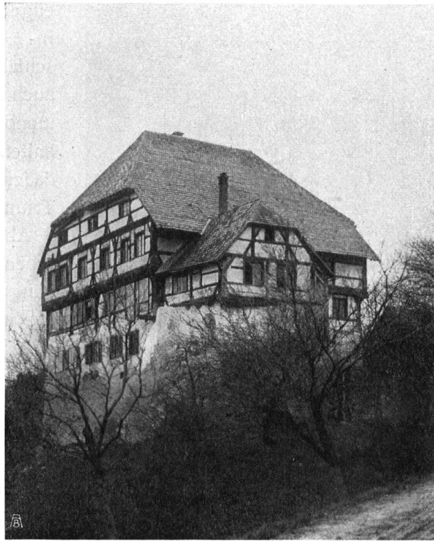
Abb. 4. Schloss Zuckenriet bei Wil. Ueber gemauertem Unterstock ein geriegelter Oberbau. Aufnahme von S. Schlatter, St. Gallen.
