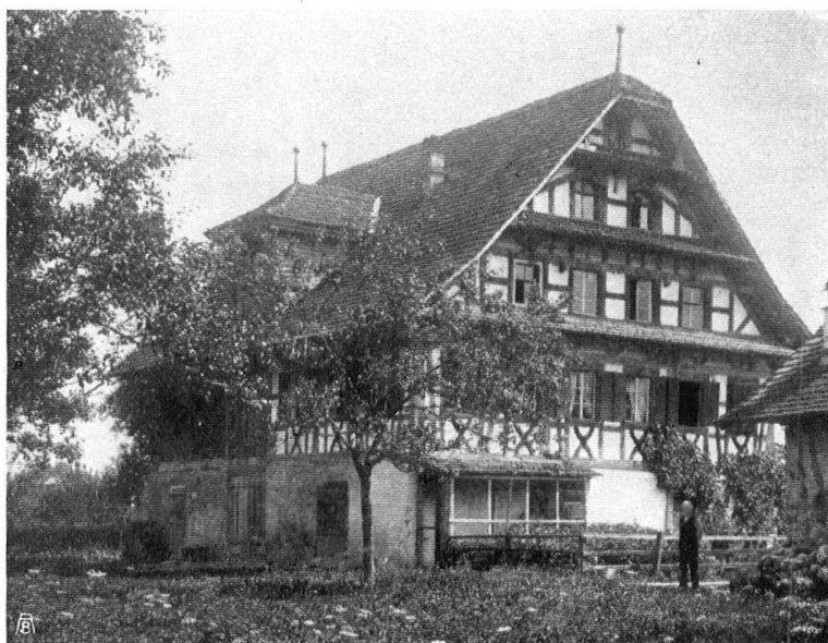
Abb. 7. Die Scheune im Grundacher zu Sarnen. Das Riegelwerk tritt hier als etwas Neues zur heimischen Bauweise mit Klebdächern und Giebelwalmung. Fig. 7. Ferme à Grundacher, près Sarnen. La maçonnerie en colombage est combinée ici avec un pignon coupé et des avant-toits protégeant la façade.
