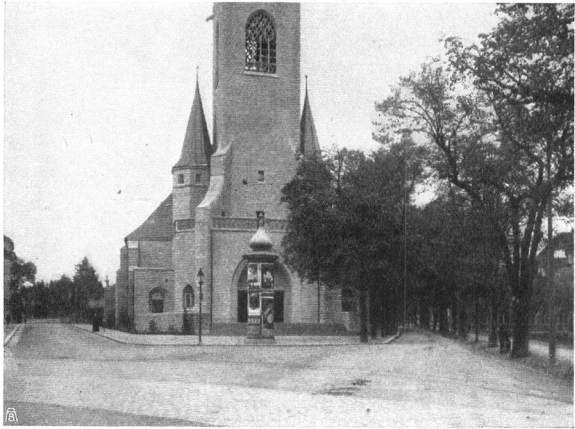
Abb. 13. Die neue St. Pauluskirche in Luzern. Die Plakatsäule vor dem Hauptportal wird der Kirche wohl noch lange zur «Zierde» gereichen, während ein paar Bäume zur rechten Seite entfernt werden! Aufnahme F. Achermann , Luzern. — Fig. 13. Eglise de Saint-Paul, à Lucerne. La colonne d'affichage devant l'église masquera sans doute longtemps encore le portail principal, tandis que les beaux arbres qui ornent la place, à droite, seront abattus. Cliché F. Achermann , Lucerne.
