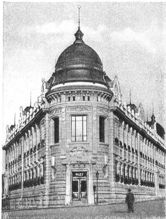
Abb. 3. Eidg. Postgebäude in Basel. Eine Steinmasse von erdrückender Schwere. — Fig. 3. Hôtel des postes fédérales de Bâle. Cube de maçonnerie d'une lourdeur écrasante.
