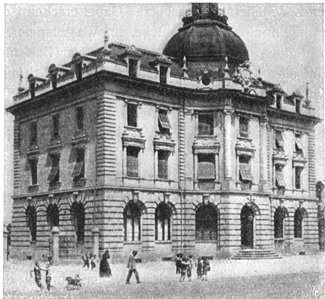
Abb. 2. Eidg. Postgebäude in Herisau. Diese trockene Kuppelarchitektur steht in der Nachbarschaft alter rassisser Appenzellerhäuser mit eigentlich monumentalen Giebeln: reichste, aber in diesem Fall ungenützte Anregung für öffentliche Bauten! – Fig. 2. Hôtel des postes fédérales de Hérisau. Cette sèche architecture couronnée d'une coupole se trouve dans le voisinage de vieilles maisons en pur style d'Appenzell, à pignons monumentaux: l'architecte public eût pu s'inspirer de ces modèles suggestifs.
