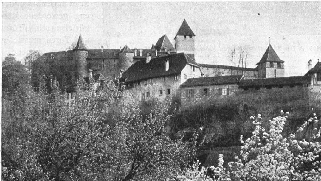
Abb. 1. Schloss Burgdorf, Nordfront. Davor die letzten Reste der Ringmauer und der, von ihnen umschlossene, alte Markt. Aufnahme von L. Bechstein , Burgdorf. — Fig. 1. Le château de Berthoud, vue du Nord. Devant le château quelques parties conservées de l'ancien mur d'enceinte et de l'ancien marché.
