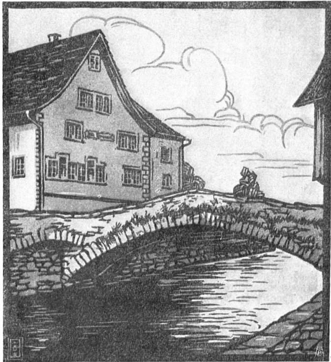
Abb. 13. Unterer Schwibbogen über die Aa in Sarnen. Die schön geformte alte Brücke muss voraussichtlich der projektierten Flusskorrektur weichen. Nach einem Linoleumschnitt von Alb. Hinter, Sachseln. — Fig. 13. Pont sur l'Aa à Sarnen qui devra malheureusement disparaître par suite de la correction de la rivière.
