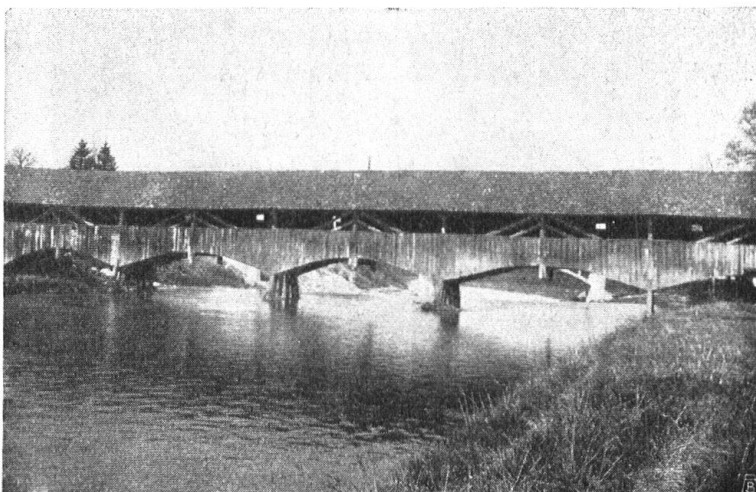
Abb. 16. Alte Thurbrücke bei Weinfelden. Interessanter, wichtig wirkender Bau; nach der Wetterseite zu seitlich geschlossen. — Fig. 16. Vieux pont sur la Thour, près de Weinfelden. Construction intéressante et d'un bel effet. Fermé par une cloison du côté de l'ouest.
