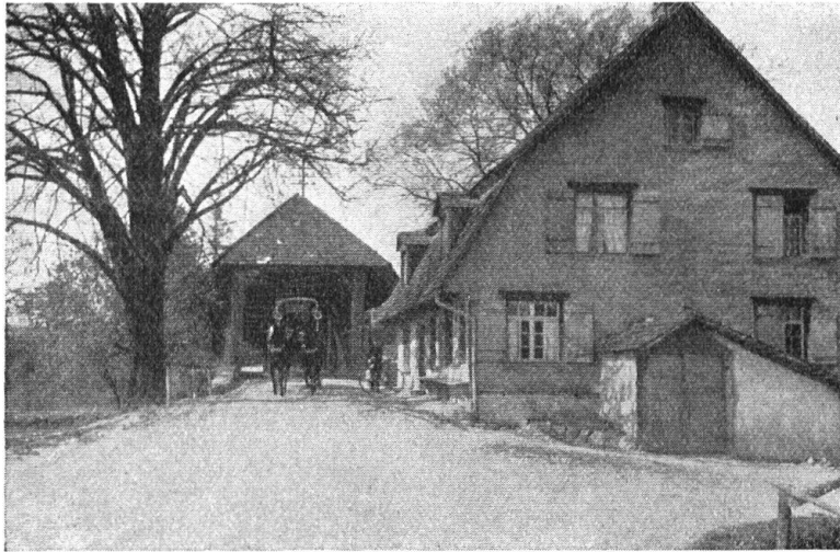
Abb. 15. Alte Thurbrücke bei Weinfelden (Thurgau). Brückenkopf mit Zollhaus; ein einheitliches, malerisches Gesamtbild. — Fig. 15. Vieux pont sur la Thour près de Weinfelden. La tête du pont et le bureau des péages. Paysage pittoresque.
