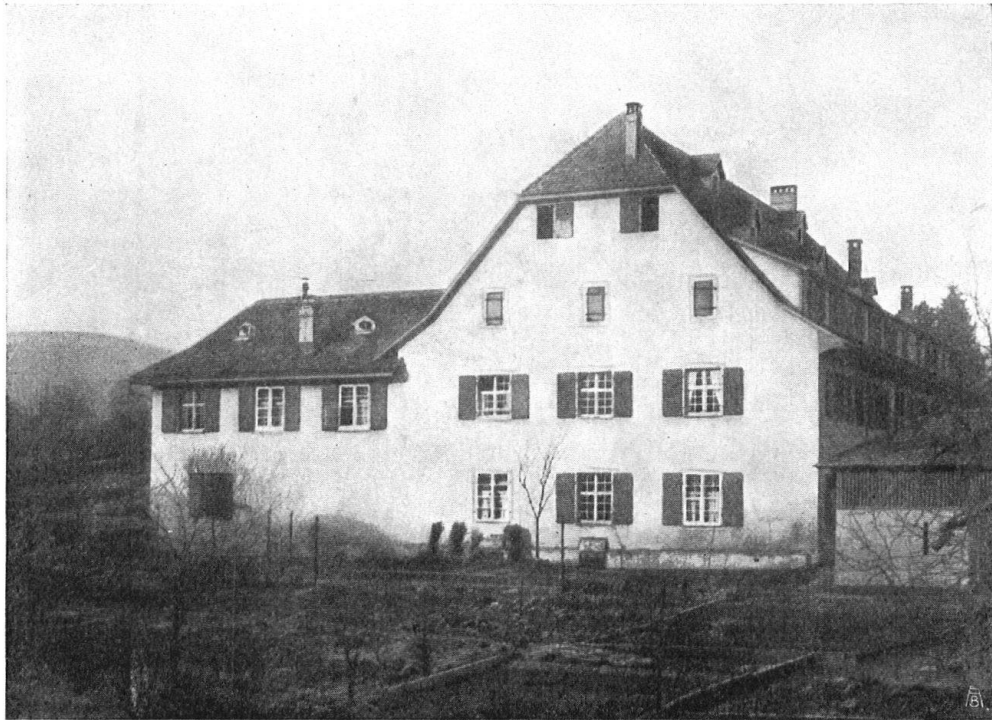
Fig. 14. Alter Spital. In den Proportionen, der Dachgestaltung wie in der Gesamtanlage ein typisches Beispiel der alten Bauweise im Baselbiet. Die Grundformen finden sich, modern umgestaltet, in den hier folgenden Neubauten wieder. (Besonders Abb. 16 und 17.) — Fig. 14. Le vieil hôpital. Exemple de construction en Bâle-Campagne, typique par ses proportions et son aspect général. Les formes essentielles se retrouvent dans les bâtiments modernes reproduits ci-après. En particulier n° 16 et 17.
