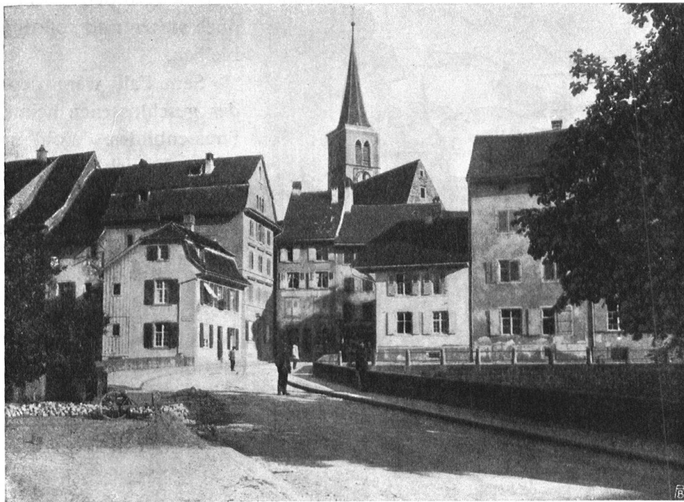
Abb. 4. Stadteingang beim ehemaligen „untern Tor“, das leider abgebrochen wurde. — Fig. 4. Entrée de la ville où s'élevait antrefois la «Tour inférieure», qui a été malheureusement démolie.
