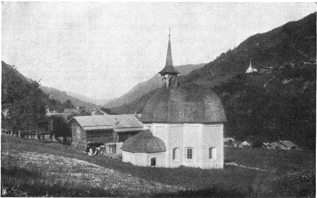
Abb. 10. Kirche von Disla. Eine barocke Anlage, wie sie für die Gegend besonders typisch ist. Beachtenswert die feine Form des heimischen Schindeldaches (und des originellen Dachreiters). Aufnahme von Photograph A. Ditisheim , Basel. – Fig. 10. Eglise de Disla. Edifice typique pour le pays. Remarquer les formes élégantes du toit de bardeaux et de l'originale tourelle.
