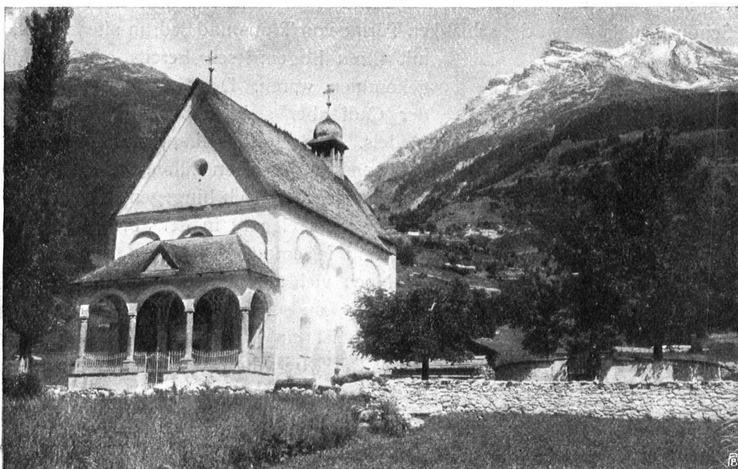
Abb. 12. Kirche zu St. Anna beim Ahorn in Truns. Die schöne Vorhalle wie die Wandgliederung verraten romanische Baukultur, die Dächer und der Dachreiter sind ganz der Umgebung eingestimmt. Aufnahme von Dr. P. C. Hager, Disentis. – Fig. 12. Eglise de Sainte-Anne non loin de l'érable de Truns. Le péristyle et l'architecture des murs latéraux dénotent l'influence romane; le toit et la tourelle sont parfaitement adaptés au style local.
