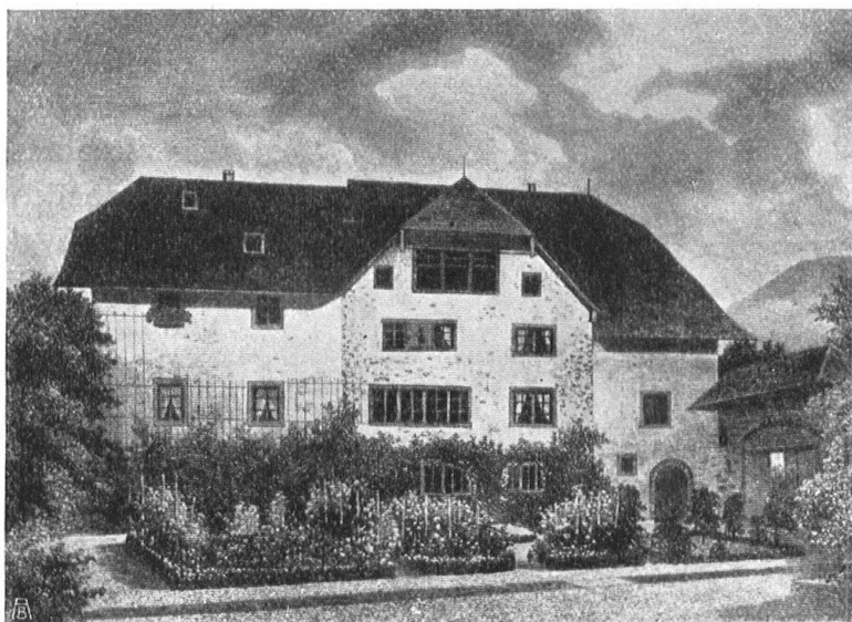
Abb. 13. Das Winkelried-Haus in Stans. Gartenansicht. Nach einer alten Zeichnung. — Fig. 13. La maison de Winkelried à Stans. Vue du jardin. D'après un ancien dessin.
