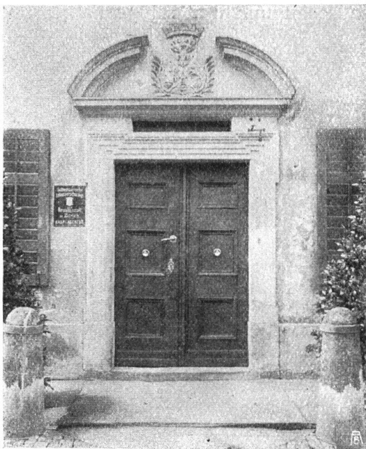
Abb. 15. Portal im Hause Flüeler in Stans. Fig. 15. Porte d'entrée de la maison Flüeler à Stans.
