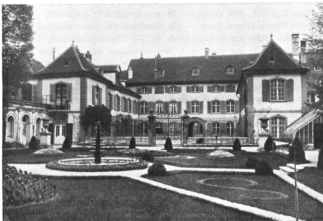
Abb. 10. Gartenfassade des Württemberger Hofes. Gegen Mitte des 18. Jahrhunderts aus einem Bau von 1570 in ein « hôtel entre cour et jardin » umgebaut. — Fig. 10. Façade sur le jardin du Württembergerhof. Ancien hôtel entre cour et jardin transformé vers le milieu du 18 e siècle.
