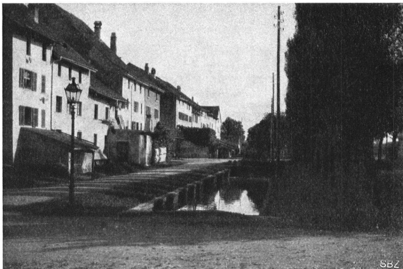
Abb. 14. Wassergraben am Südrand von Neunkirch. Fig. 14. Fossés au sud de Neunkirch.
