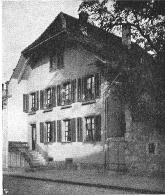
Abb. 8. Auf dem Rain. An der Fassade und im abgewalmten Giebel ist der Einfluss bernischer Bauart bemerkbar. Aufnahme von K. Ramseyer. — Fig. 8. Sur le Rain. La façade et le pignon à pan coupé trahit l'influence bernoise.
