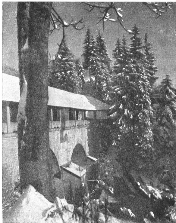
Abb. 6. Die Teufelsbrücke. Auf zwei wuchtigen Sandsteingewölben eine überdeckte Fahrbahn; der Brückenkopf von Tannen umgeben. — Fig. 6. Le pont du diable. Pont couvert, sur deux puissantes arches en molasse. L'entrée protégée par un petit bois de sapins.
