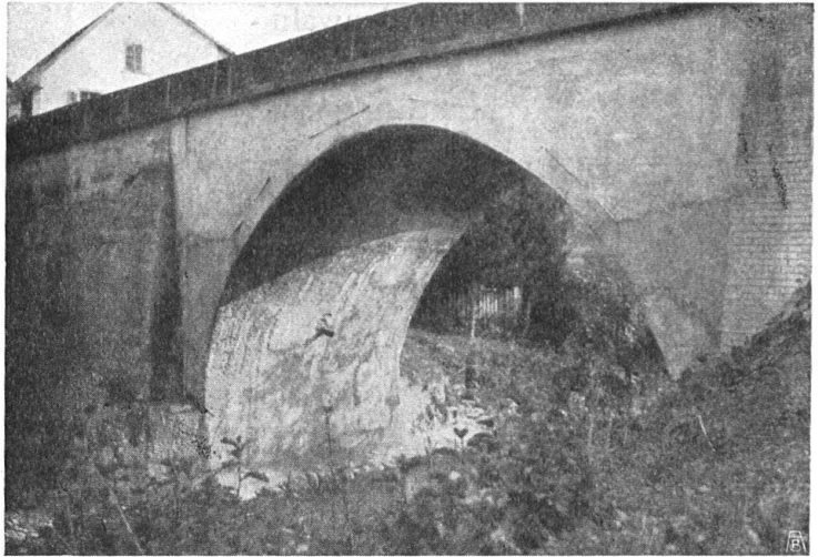
Abb. 8. Gewölbte Steinbrücke über die Biber. Imposante Masse, die sich trefflich der Landschaft einfügt. Verwerflich der Verputz mit Zementziegeln am vordern Pfeiler. — Pont de pierre sur la Biber. Masse imposante qui est en parfait accord avec le paysage. Il faut critiquer le revêtement en briques du ciment du premier pilier.
