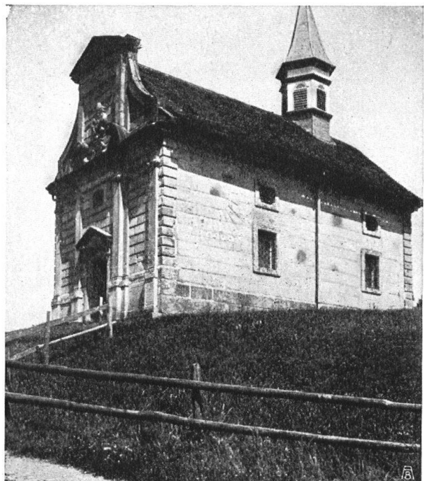
Abb. 16. Kapelle des hl. Meinrad auf der Etzel-Passhöhe. Reiche Gestaltung der schön gegliederten Sandsteinfassade. Fig. 16. Chapelle de Saint-Meinrad sur la hauteur du col de l'Etzel Riche et harmonieuse façade en molasse.
