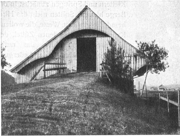
Abb. 10. Stall mit Einfahr in Seitenansicht, elegante Dachform, aber fabrikmässig wirkende Schiebetüre. — Fig. 10. Ecuries avec leur porte d'entrée, vues de côté. Les formes du toit sont élégantes; la porte à coulisse, par contre, est une porte de fabrique fort banale.
