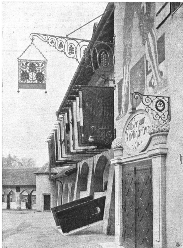
Abb. 1. Allhier zum Röseligarten. Wirtshaustor, Schild und Fahnenburg. — Fig. 1. Détails divers du Röseligarten: la porte de l'auberge, l'enseigne, les drapeaux.
