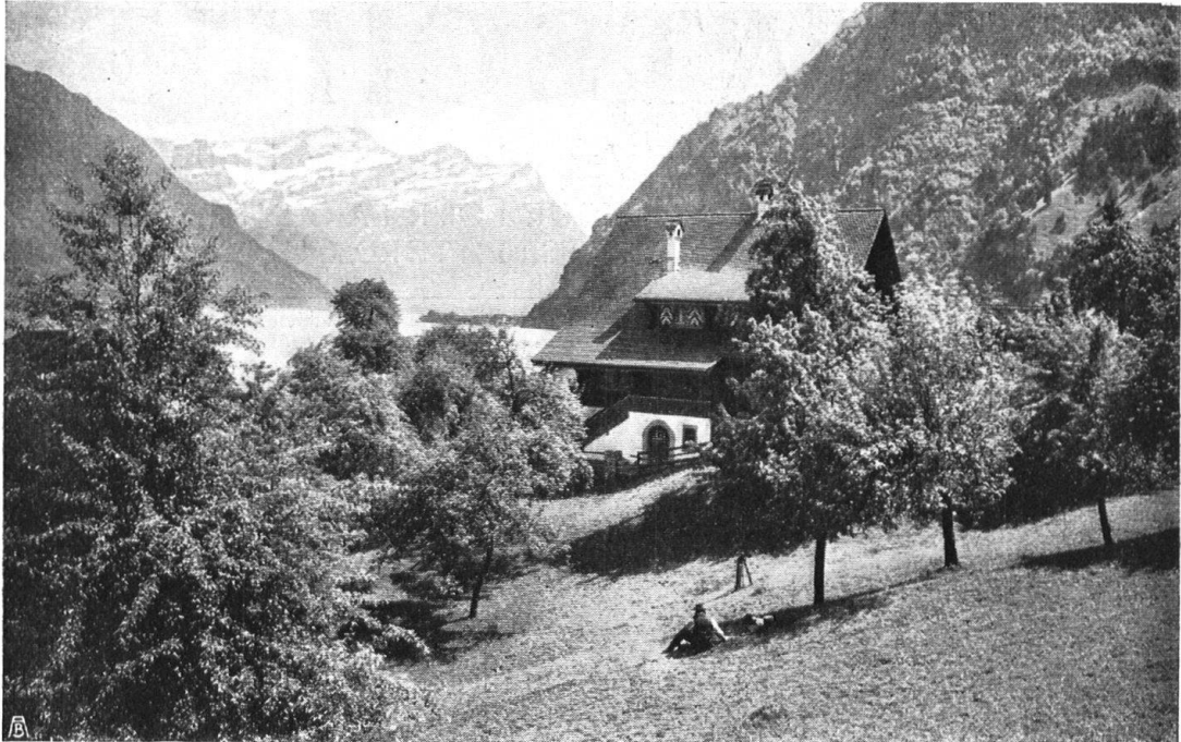
Abb. 2. Schulhaus in Bauen. Als verschindelter hochfirstiger Holzbau erscheint das Schulhaus mit dem baumreichen, idyllischen Gelände eigentlich verwachsen. — Fig. 2. Maison d'école à Bauen. Bâtiment au pignon élevé recouvert de bardeaux, architecture en si parfait accord avec la nature ambiante qu'elle semble naître du sol même.
