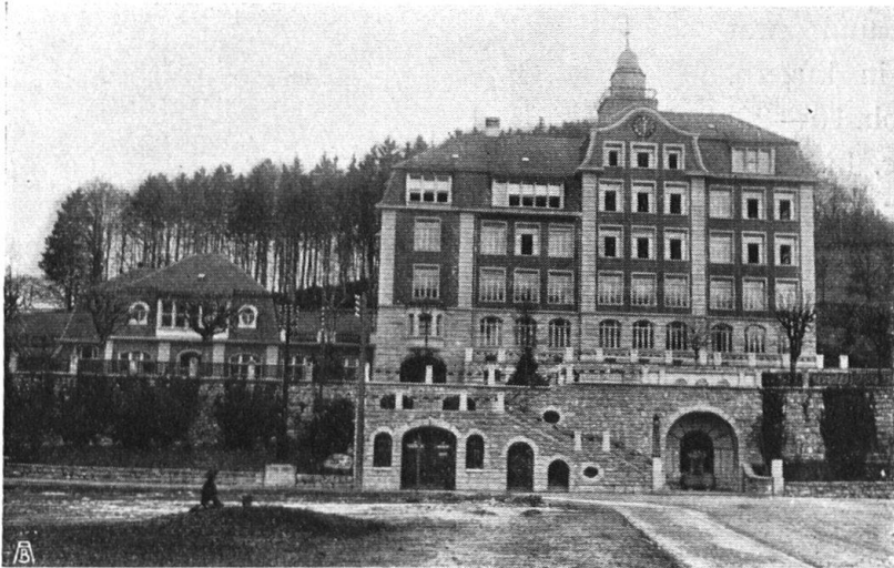
Abb. 22. St. Karli-Schulhaus zu Luzern. (Architektur der städtischen Baudirektion.) Der zu hohe Bau erscheint aus vier sich fremden Stücken zusammengesetzt; es fehlt die zwingende, grosse Linie, die das Ganze verbinden würde. Erker und Dachreiter wirken nur als Zutaten, desgleichen die Turnhalle (links aussen). — Fig. 22. Ecole St-Karli à Lucerne. Architecture officielle de la ville. Le bâtiment a l'air d'être composé de quatre éléments tout à fait étrangers l'un à l'autre. Il y manque une ligne vigoureuse qui donnerait au tout sa liaison organique. L'encorbellement, la tourelle ont l'air d'être des adjonctions sans aucun rapport avec le corps principal. La salle de gymnastique à gauche également.
