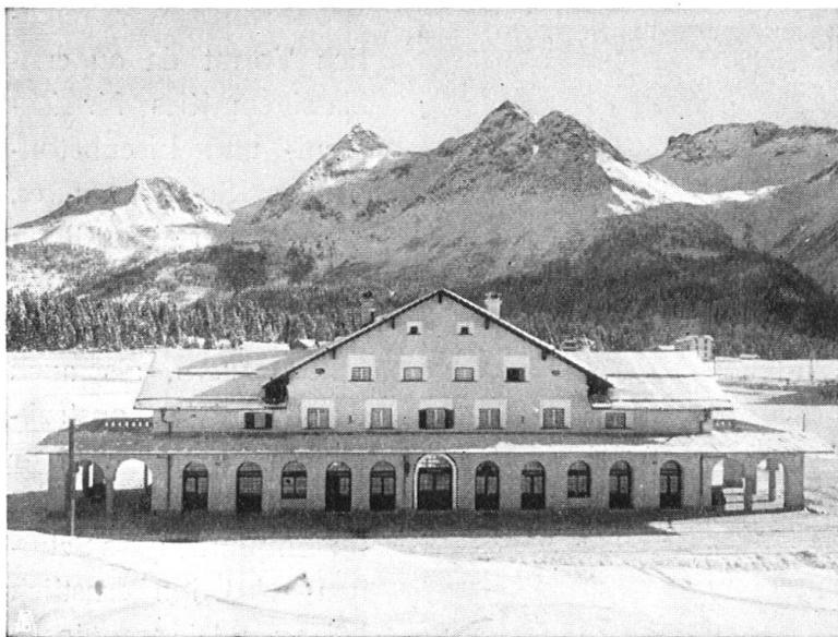
Abb. 14. Stationsgebäude in Arosa. Breit und behäbig in der Landschaft liegend. Man beachte die tiefen Fenster nach heimischer Art, die gedeckte Bogenhalle um das Haus als Warteraum im Freien. Architekten B. S. A. Meier & Arter, Zürich. Aufnahme von Junginger-Hefti, Arosa. — Fig. 14. Gare d'Arosa. Bâtiment large et commode, dont les proportions spacieuses répètent avec bonheur les lignes du paysage. Remarquer les fenêtres de style grison, et le beau portique, ou galerie couverte, qui sert de salle d'attente.
