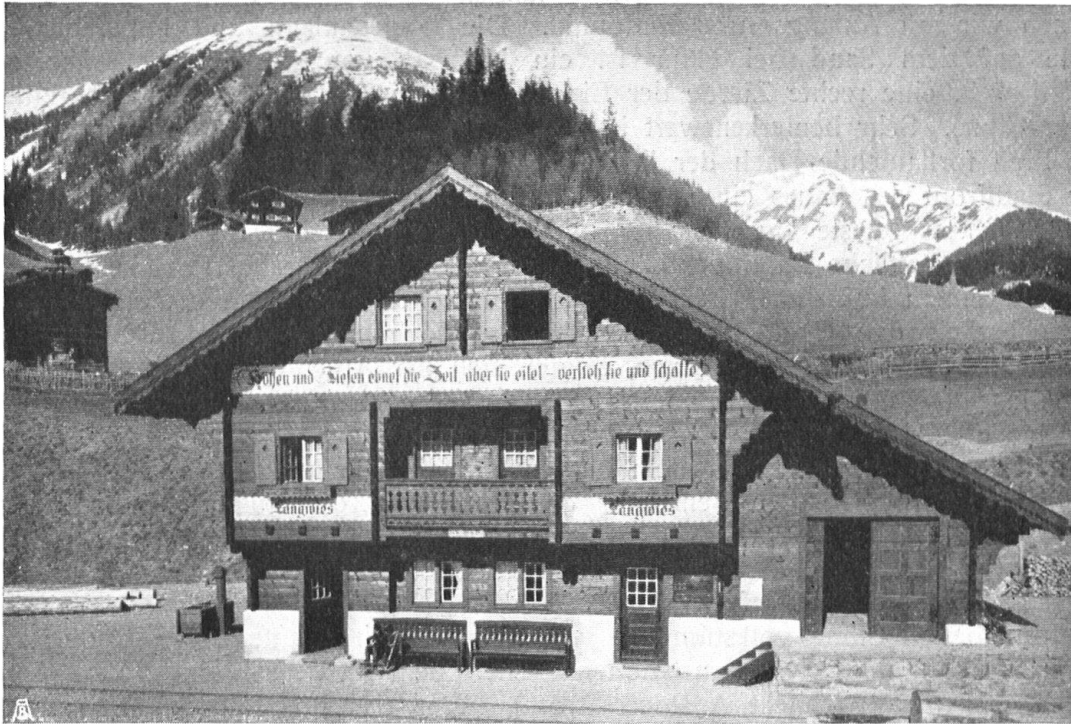
Abb. 15. Bahnhof Langwies. Die bodenständige Holzbauweise hat da eine kunstvolle und praktisch sehr brauchbare Weiterbildung gefunden. Architekt B. S. A. A. Rocco , Arosa. Aufnahme von Albert Steiner , St. Moritz. Fig. 15. Gare de Langwies. L'architecture en bois du pays a trouvé ici une heureuse application.
