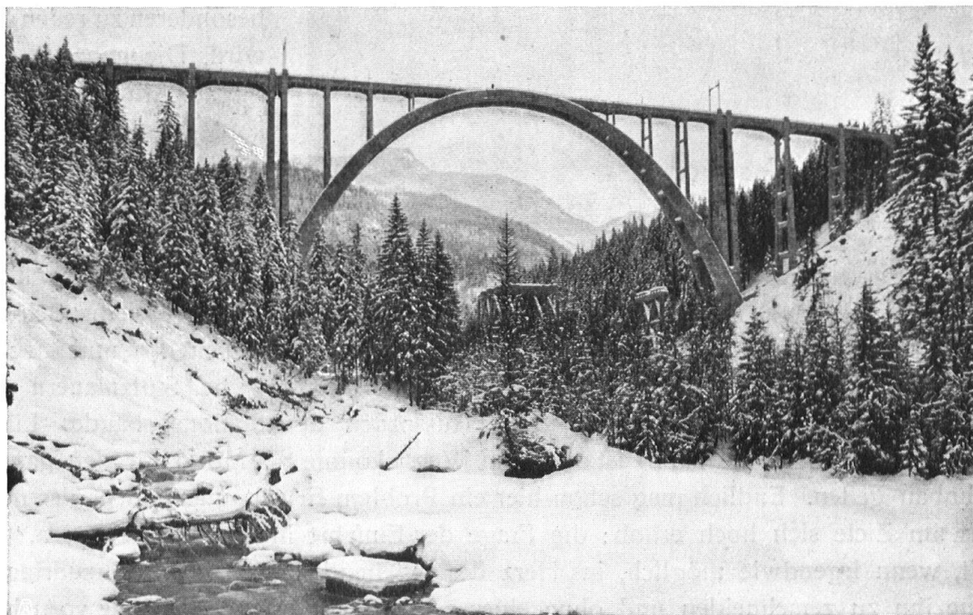
Abb. 1. Langwieser Viadukt. Aus armiertem Beton; Firma Züblin & Cie., Zürich. Gesamtlänge 285 m. Aufnahme von A. Reinhard, Chur. — Fig. 1. Le viaduc de Langwies Béton armé. Longueur totale 285 m. Diamètre de la plus grande arche 100 m.
