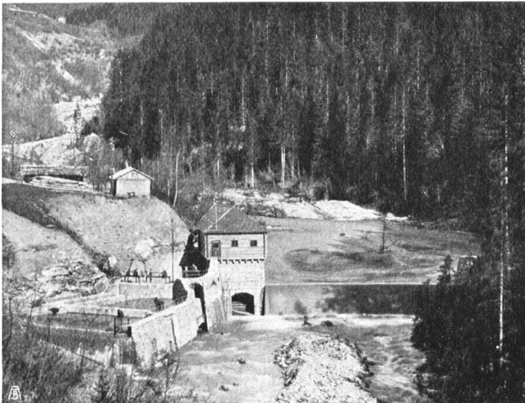
Abb. 12. Stauwehr und Klärungsanlage des Elektrizitätswerkes der Stadt Chur bei Molinis. Nutzbau in schlichten, doch der Gegend angepassten, rassigen Architekturformen. Aufnahme von A. Reinhard, Chur. — Fig. 12. Barrage et installations hydrauliques des usines électriques de la ville de Coïre près Molinis. Bâtiment simple, mais qui ne manque pas de caractère, et qui est adapté à la rudesse de la contrée.
