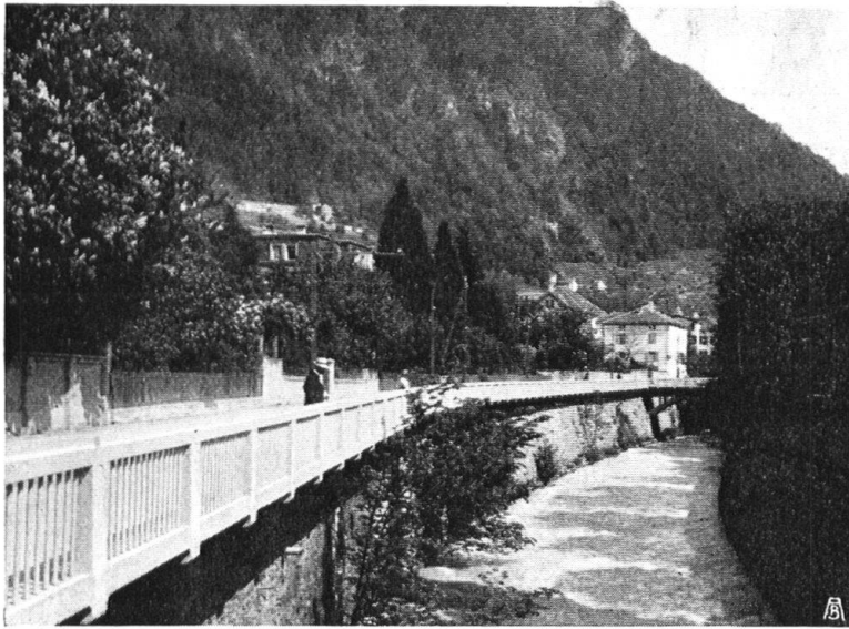
Abb. 2. Plessurquai in Chur. Der Verkehr forderte eine Verbreiterung, welche nun, unter Schonung der Uferpartie, durch den Bau eines Auskragtrottoirs in armiertem Beton erreicht ist. Aufnahme von A. Reinhard, Chur. — Fig. 2. Quais de la Plessur à Coire. La circulation exigeait un élargissement de la route, qui a été obtenu par un trottoir en surplomb en béton armé, et les rives de la Plessur ont été ainsi épargnées.
