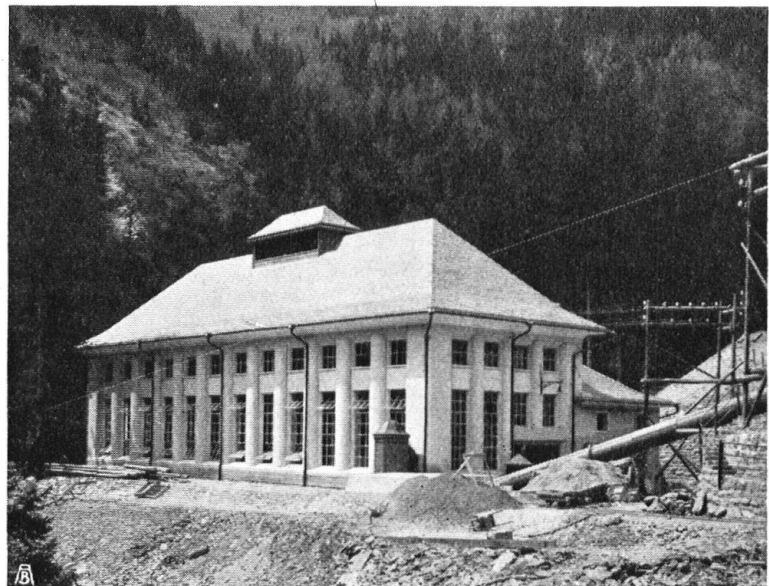
Abb. 10. Maschinenhaus des Elektrizitätswerkes der Stadt Chur. Durch gute Proportionen und streng durchgeführte Gliederung wuchtig und schön wirkende Nutzbau, der trefflich in die raue Umgebung passt. Architekt B. S. A. Willi, Chur. Aufnahmen von A. Reinhard, Chur. — Fig. 10. La halle aux machines de l'usine électrique, à Coire. Des proportions justes, des lignes vigoureuses, la sévère régularité des divers éléments donnent à ce bâtiment un caractère très approprié au paysage ambiant.
