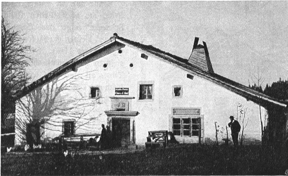
Abb. 6. Jurassisches Bauernhaus von 1612, in Chaux-d'Abel. Besonders typisch für die jurassische Dachgestaltung. Aufnahme von J. Arn, St.-Imier. — Fig. 6. Ferme jurassienne, de 1612, à la Chaux-d'Abel. Exemple caractéristique de toit jurassien.
