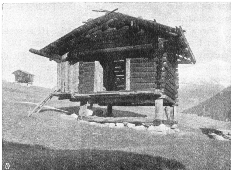
Abb. 2. Kornspeicher auf der Längmatte in Frauenkirch-Davos. Aufnahme von Rudolf Gabarel, Davos. — Fig. 2. Grenier à la Längmatte, Frauenkirch-Davos.
