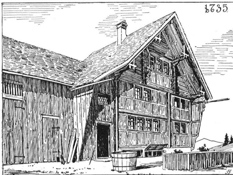
Abb. 3. Appenzellerhaus in Farnbühl bei Stein; gestrickt, mit Nageldäch und Wetterschilden zum Schutz der Hausfront. Federzeichnung von S. Schlatter. Fig. 3. Maison appenzelloise à Farnbühl, près Stein. Toit de tavillons. Façade en bois protégée par des parois latérales.
